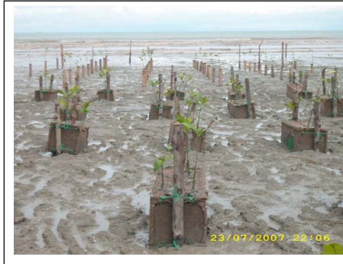
Gambar 13 : Probing penanaman di pantai Kg. Sg. Yu, Kuala Kedah dengan teknik BEM dan Comp-mat tanpa geotub sebagai pemecah ombak
