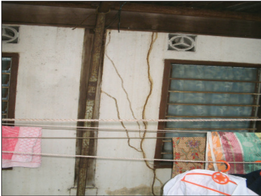
Fig. 22. Nasutitermes sp. mud tubes.
